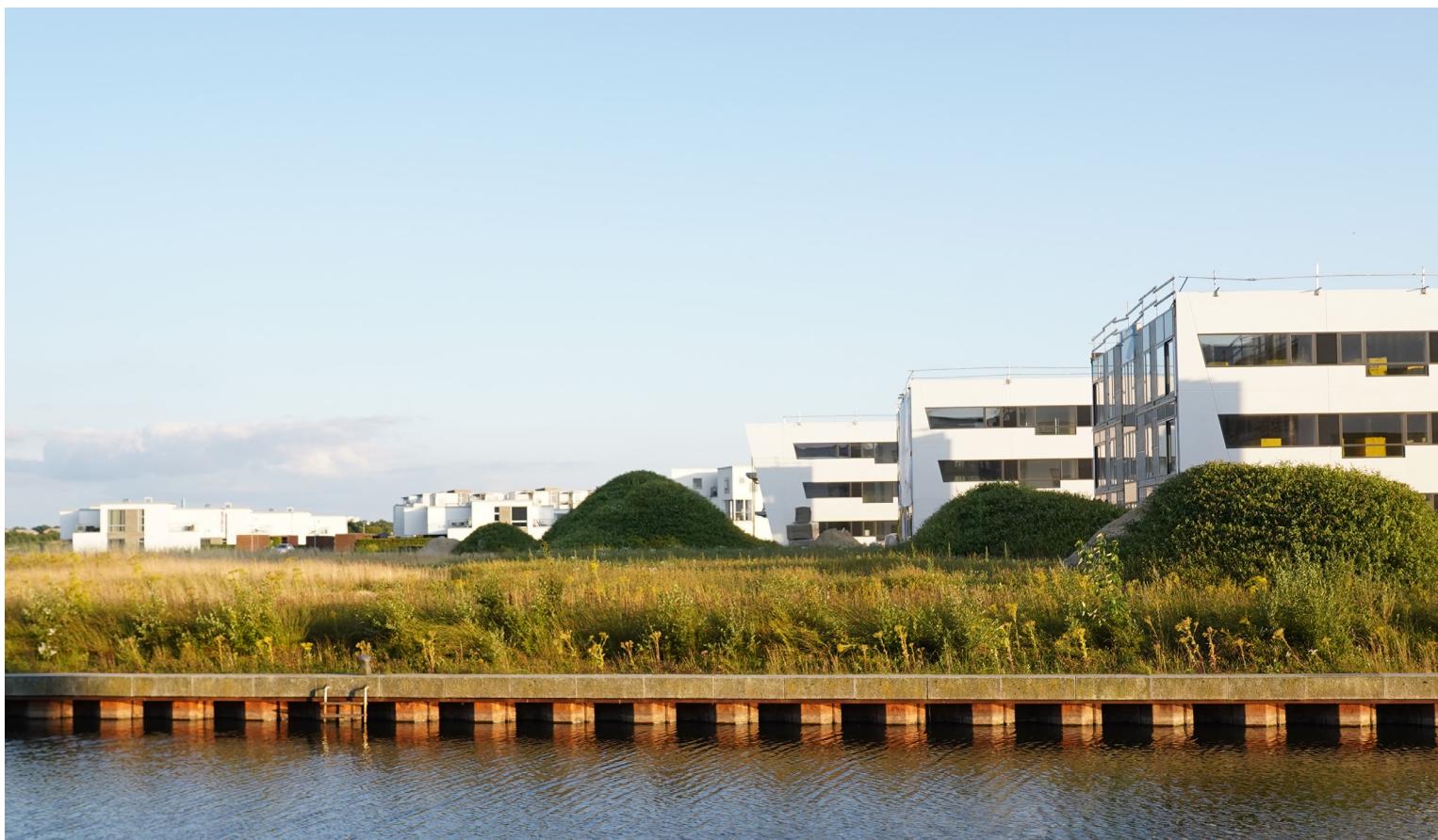
Eksempel på byggeri med PP Nordicas nye konstruktionsfibre i armeringen.
